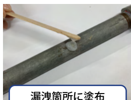
漏洩箇所に塗布
